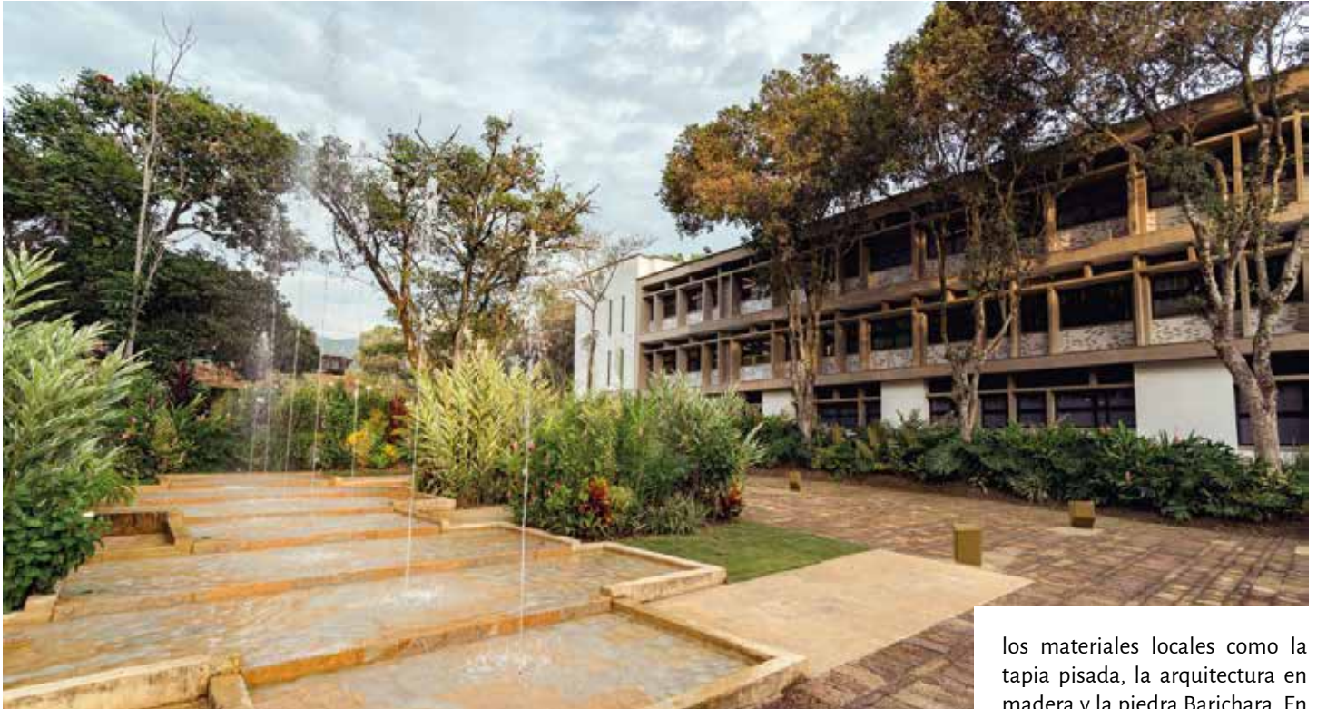
◆ El edificio Administración 1, del campus principal, fue diseñada originalmente por el arquitecto Mario Pilonieta en 1958 y la remodelación, a cargo del arquitecto Helmer Fabián Camargo Rincón, participa en la Bienal Colombiana.
